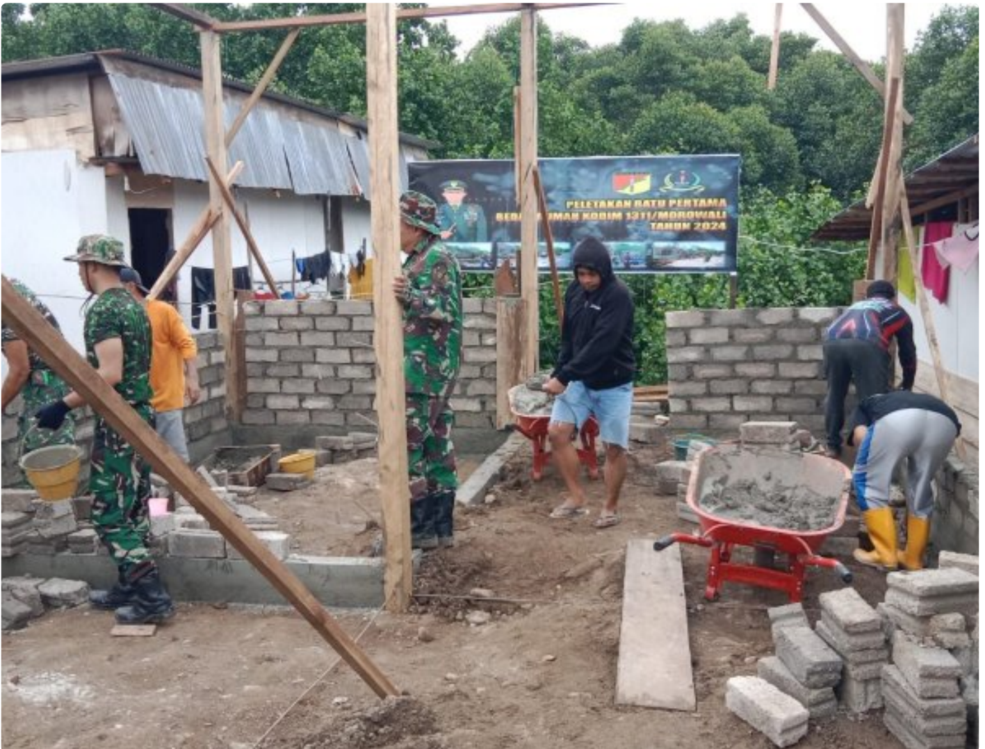
Tampak pengerjaan bedah rumah tahap pemasangan Batako
