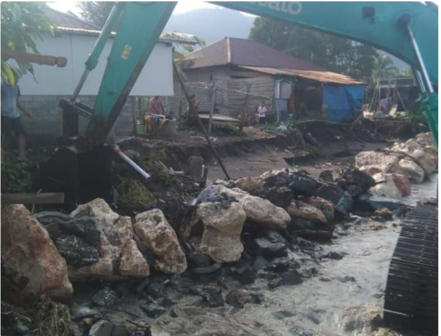
Proyek pemecah ombak di desa kolono
